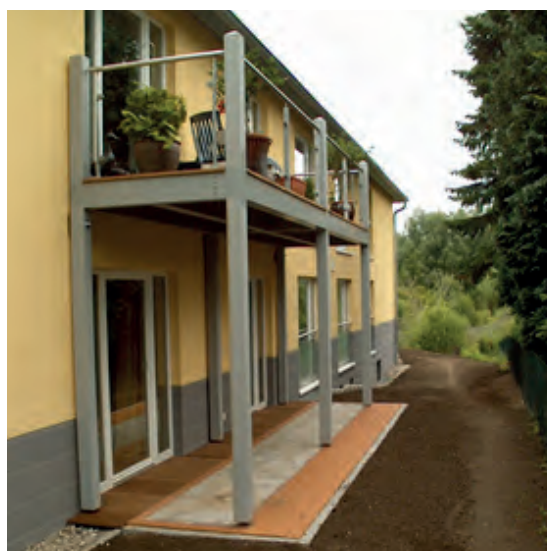
Balkonanlage mit offenem Belag in Nutzungsklasse 3
