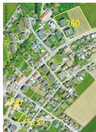
Grundstücke der BG Gunzgen: Parzelle 260 mit geplanter Überbauung und neu gekaufte Parzellen 990 und 1134.
