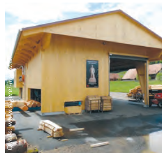
Neue Halle der Sägerei Ingold, Ichertswil
