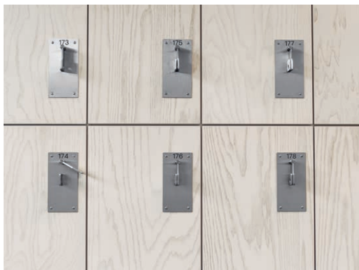
Die Verschlüsse der Spinde wurden vom Schlosser nach dem Vorbild der alten Schule nachgebaut.
